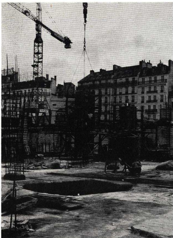
Photo 3. — COFFRAGES MÉTALLIQUES DE POTEAUX.
