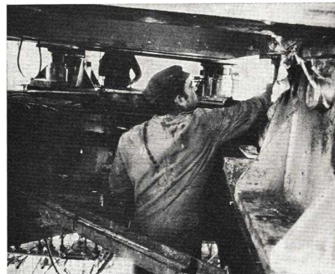
Fig. 107. — Fin du ripage du portique arrière. Le profilé supérieur de translation va être enlevé et, après descente sur vérin du portique arrière, se déplacera pendant son pivotement autour du chariot avant, sur le profilé inférieur supportant un rail circulaire.
