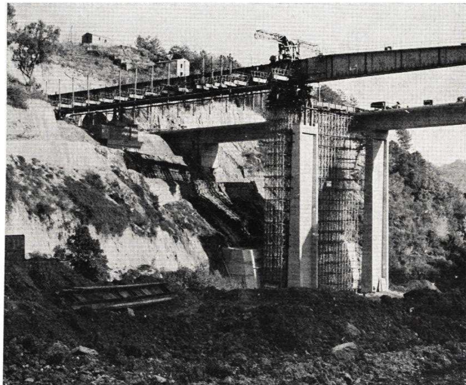
Fig. 119. — Fin de l'opération. Le cintre repose sur portique arrière et sur la palée sur pile. Il est prêt à être lancé dès que seront montés les planchers et démonté le chariot de ripage ainsi que la partie supérieure de l'estacade.
