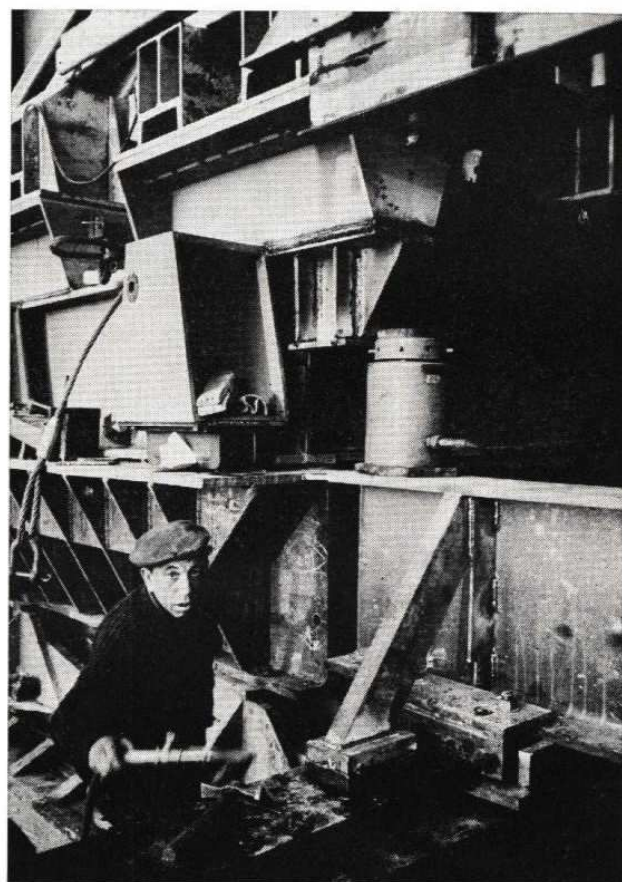
Fig. 93 et 94. — Accostage du portique avant sur les profilés HEB 800, chemin de roulement du ripage.
