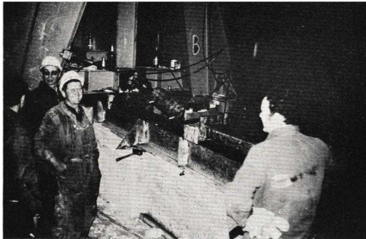
Fig. 101. — Ripage du portique arrière. Deux régulateurs de débit assurent une vitesse de déplacement égale au portique arrière et au chariot avant, évitant tout coincement et, par suite, tout effort transversal sur l'estacade.
