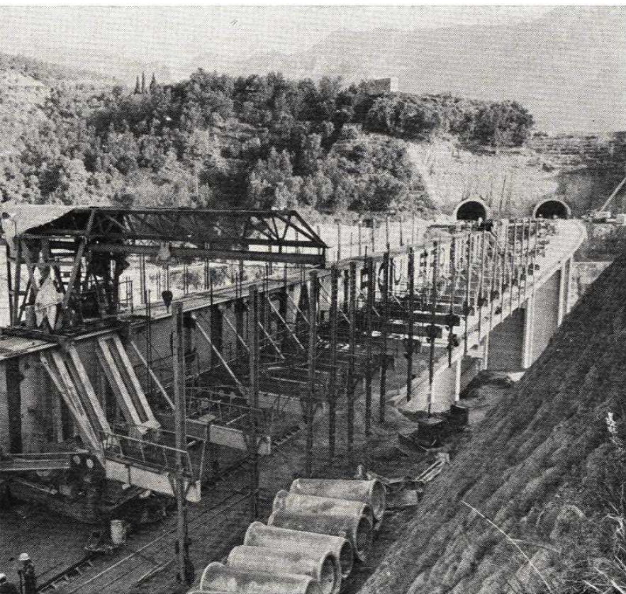
Fig. 72. — Recul du cintre du Pescaire au Pala avant ripage de la plateforme pour l'exécution de la seconde voie. Au premier plan, le portique avant situé juste en arrière de l'élément d'articulation du cintre.
