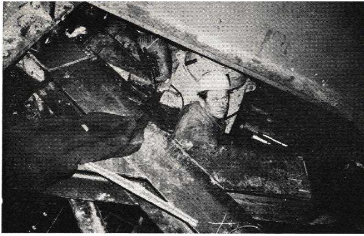
Fig. 116. — Pivotement du cintre sur la tête du vérin de 500 t.
