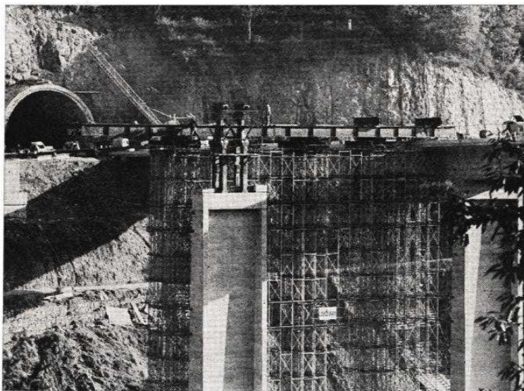
Fig. 82. — Pose de la palée sur pile devant recevoir le cintre après pivotement et descente sur vérins. Pose, à l'aide d'un chariot provisoire roulant sur les HEB 800, la pile étant inaccessible aux grues de chantier.
