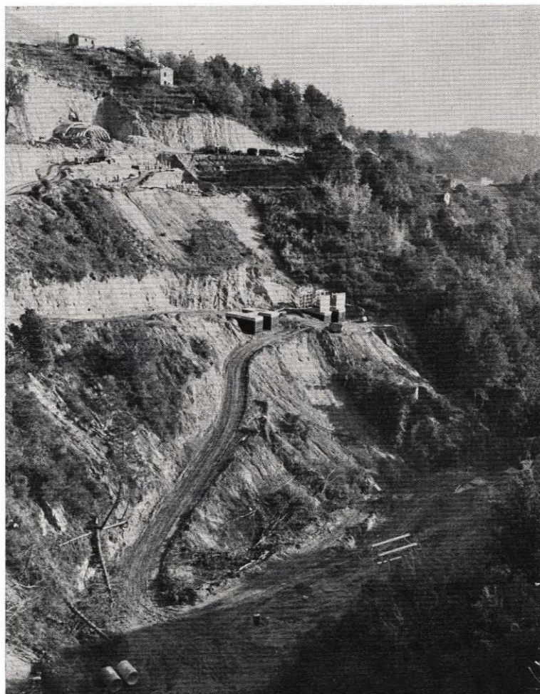
Fig.1. — Viaducs du PALA. Piste d'accès aux piles sur versant raide.
