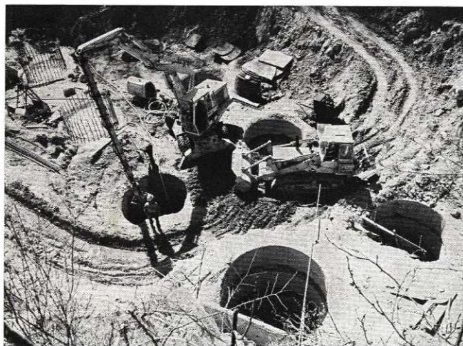
Fig. 3. — Exécution de puits en fond de vallon.
