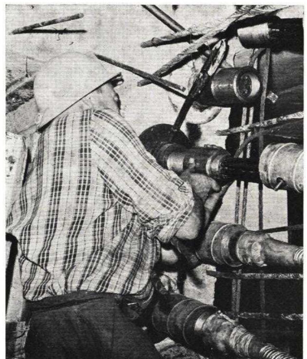
— Dépose des haubans. — Butonnage de la palée par profilé soudé sous le caisson à l'avant des rouleaux.
