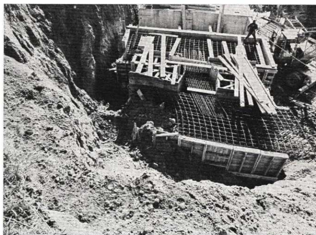
Fig. 4. — Exécution des fondations : éboulements. L'impossibilité de taluter les versants sans compromettre l'appui supérieur d'une part, et l'impossibilité de blinder du fait de la pente du versant d'autre part, ont conduit, dans de nombreux cas, à des éboulements ou, parfois, même à des glissements de terrain importants.
