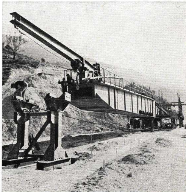
Fig. 71. — Roulage de la partie avant.
