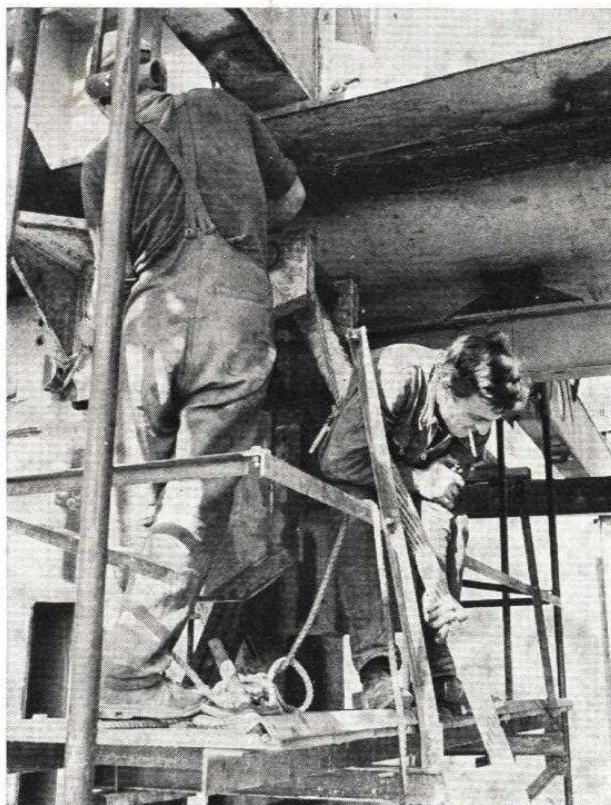
— Réglage des panneaux extérieurs : butonnage du pied par tendeurs, réglage du premier volet sur fourches, réglage du deuxième volet par fourches et étais.
