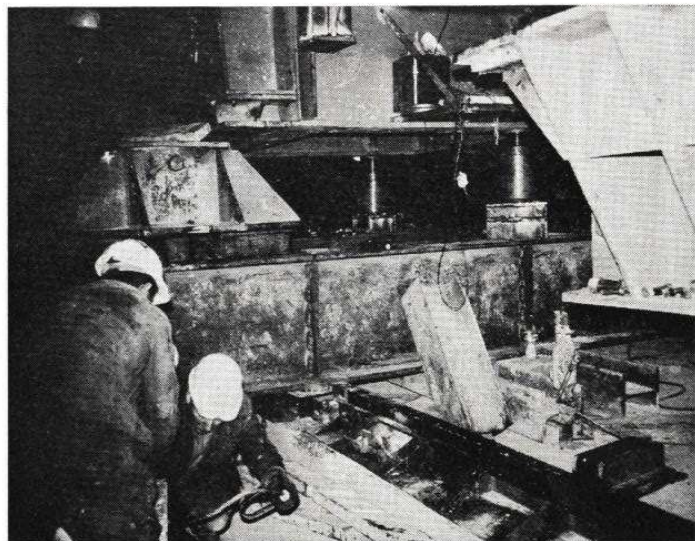
Fig. 100. — Préparatifs de ripage du portique arr. Introduction du profilé HEB 300 servant de rail. Fixa de rouleurs de 100 t entre ce profilé et le portique. Fixa des dispositifs de guidage (patins latéraux) et de pous: vérin de 30 t.
